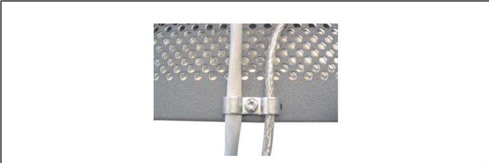
Abbildung 44: Kabelschellenfixierung
