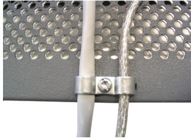
Abbildung 92: Kabelschellenfixierung
