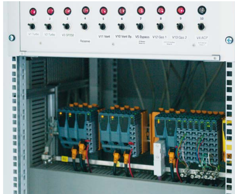
Ob sich die Satelliten für den Einsatz im Weltraum eignen, testen die Wissenschaftler mithilfe einer manuellen Thermal-Vakuum-Kammer. Die Steuerung der Kammer übernimmt eine X20-Steuerung sowie weitere X20-Komponenten von B&R.
