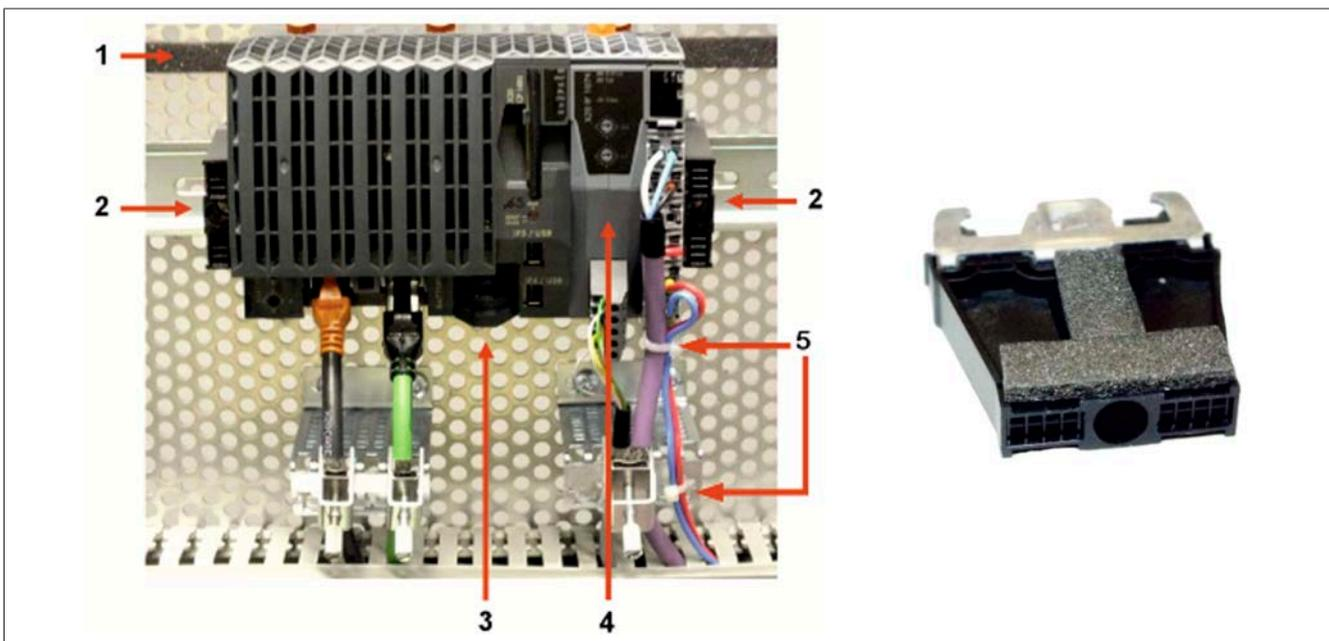
Abbildung 2: X20 System - Montage bei erhöhten Vibrationsanforderungen (4 g) und Endklammer
